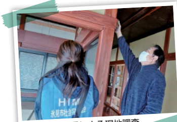
職員による現地調査
